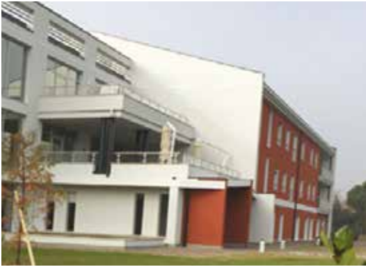
Casa Di Riposo Di Marghera Marghera - Venezia
